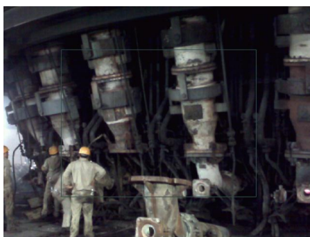
メンテナンススタッフが高炉送風支管を補修している
