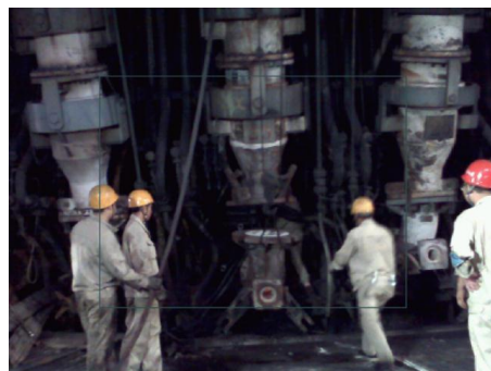
メンテナンススタッフが高炉送風支管を補修している
