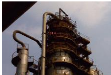
蒸留塔ライニングが脱落して、温度異常が引き起こされた
