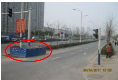
漏れの箇所を調べた後当該箇所に補修を行った
