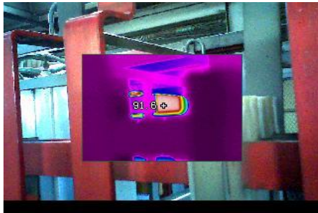
メイン変圧器の高力率電圧調整抵抗
